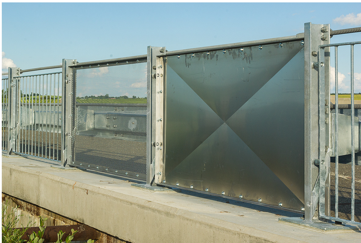
Obrázek 15 – Zábradelní svodidlo ZMS4/H3 – rám pro výplň ze sítě, z tahokovu a pro plnou výplň
